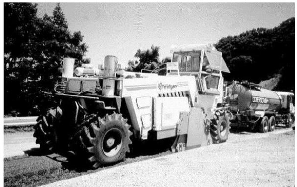
写真-2 路上破碎混合機(供給車併走タイプ)
